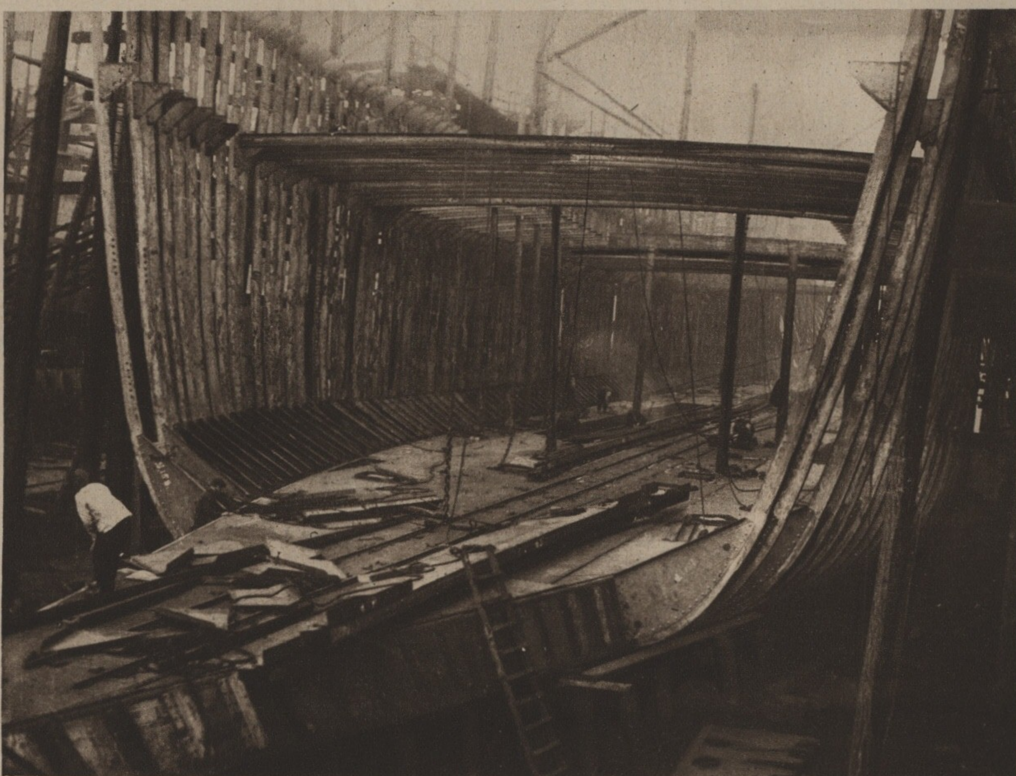
Construction des sous-marins
