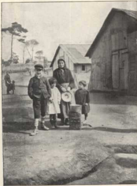
Au Camp Oddo, à Marseille, 2317 réfugiés. Une installation provisoire.....
