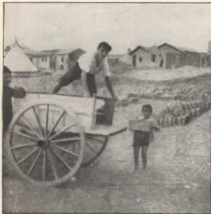
Transport des plots de terre pour la maison qui remplacera la tente.
